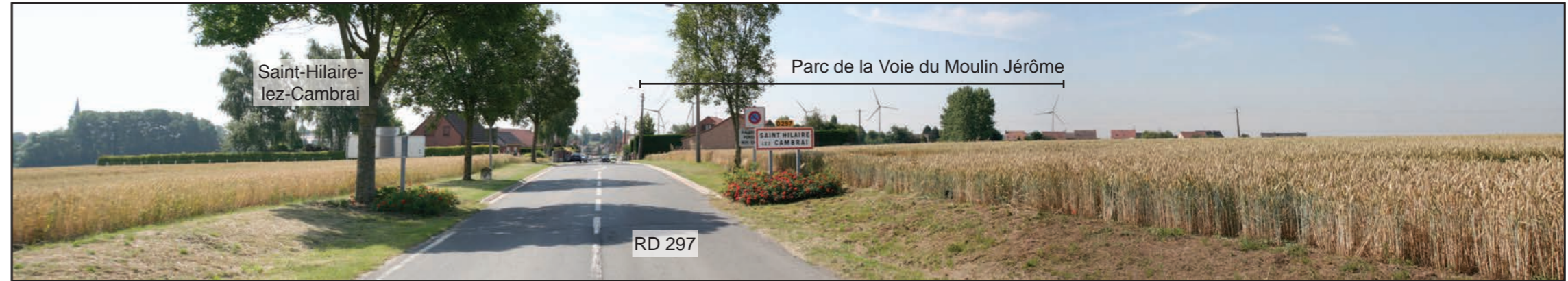
État initial - Vue panoramique
