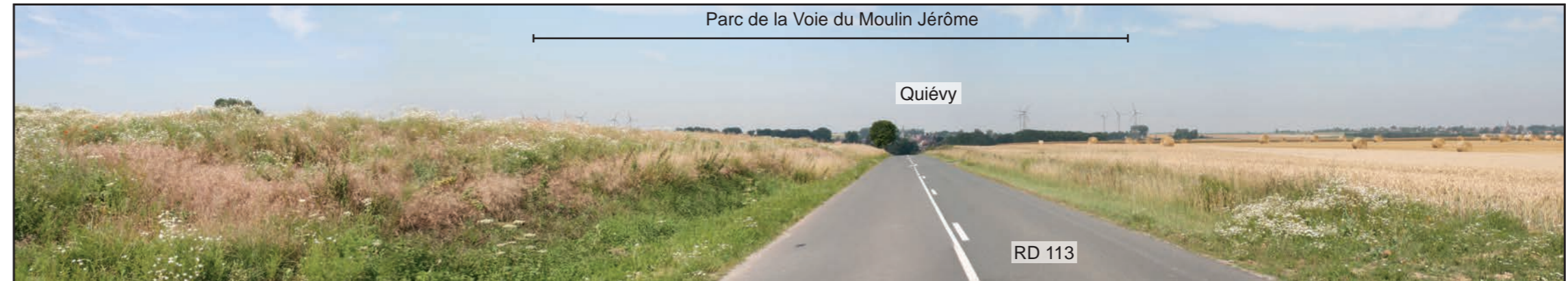
État initial - Vue panoramique
