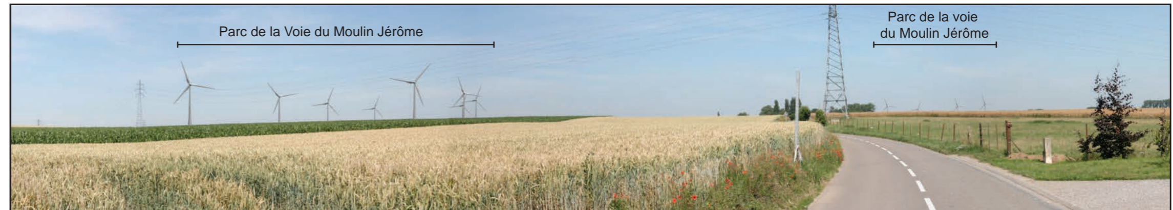
État initial - Vue panoramique
