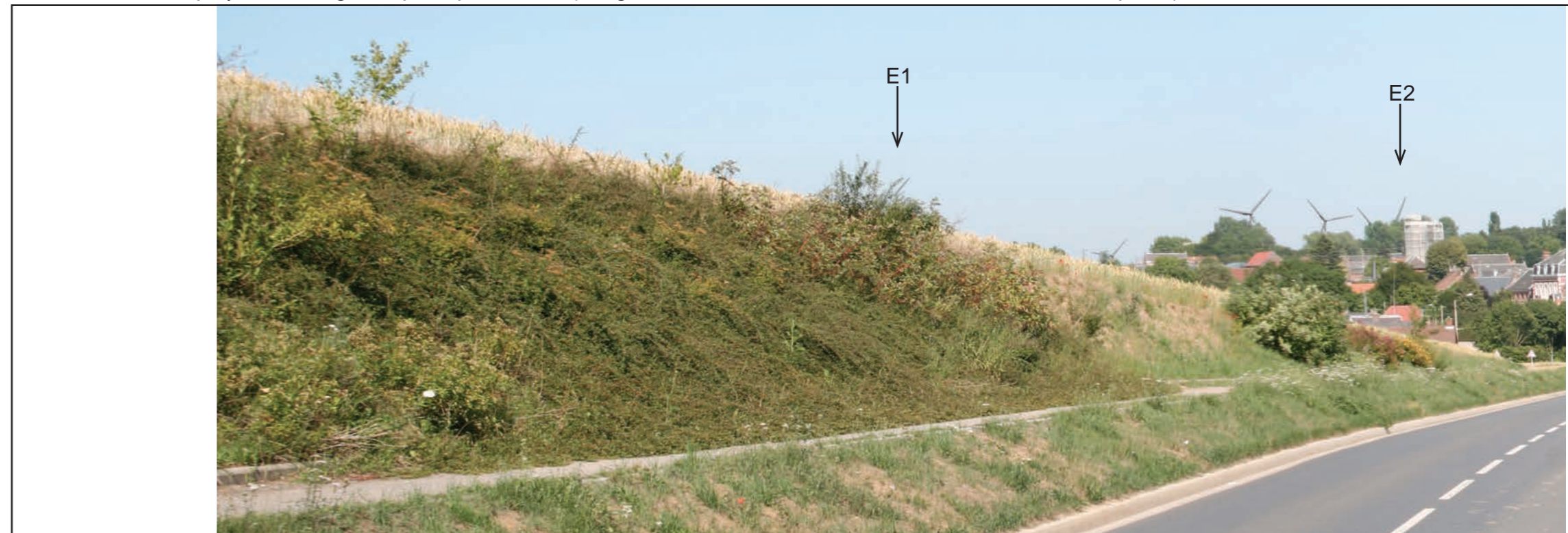
Simulation avec le projet : vue large, en perception réelle (à regarder avec une distance de 40 cm entre l'oeil et la photo)
