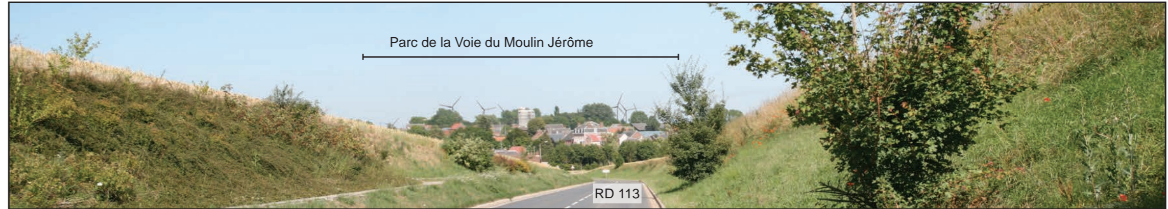
État initial - Vue panoramique
