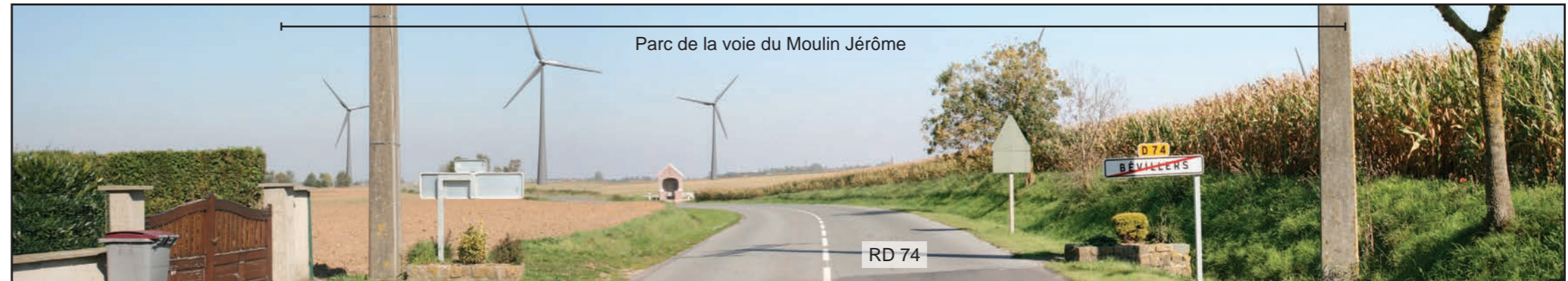
État initial - Vue panoramique
