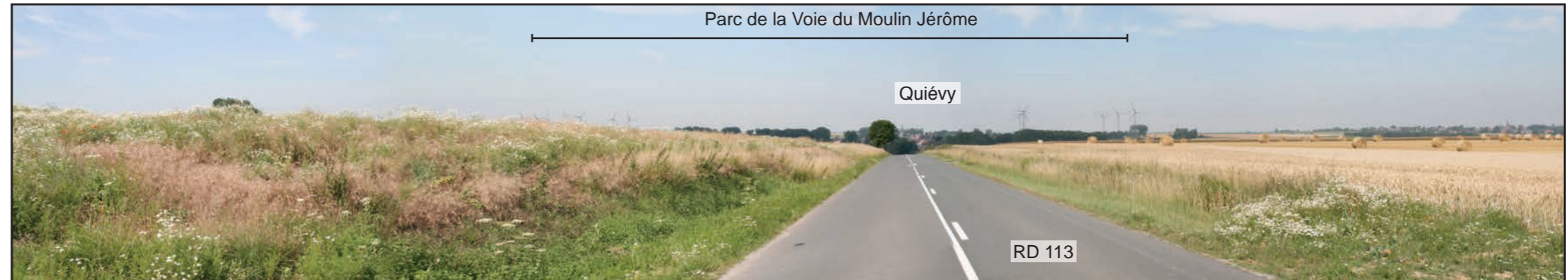
État initial - Vue panoramique
