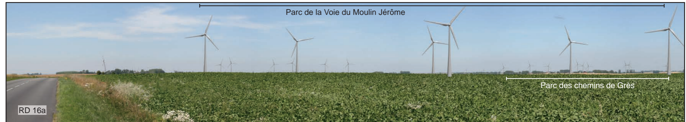
État initial - Vue panoramique
