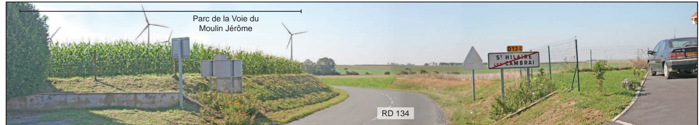
État initial - Vue panoramique
